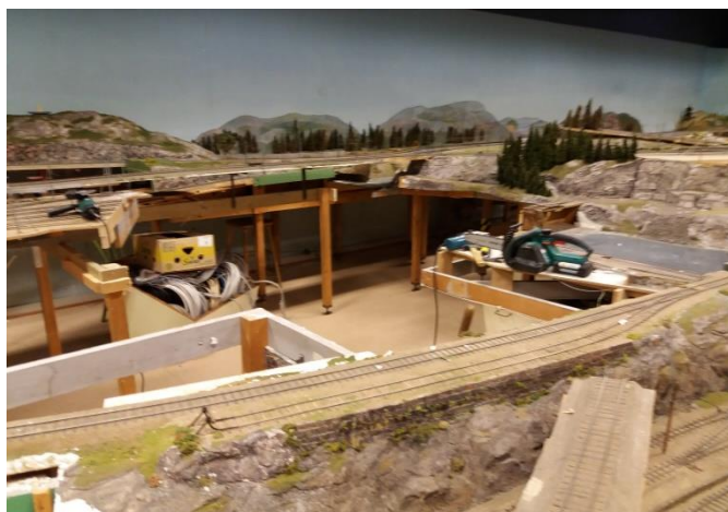
Ansvarig för nedmonteringsarbetet var undertecknad redaktör. Här är mina favoritverktyg, Motorsåg, vinkelslip och sticksåg. Kofot också förresten.
